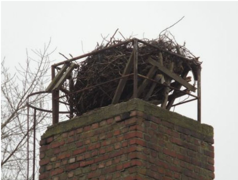
Das schwere Nest hat die marode, alte Nisthilfe zum Einsturz gebracht. Foto: A. Hornburg, 5.3.16
